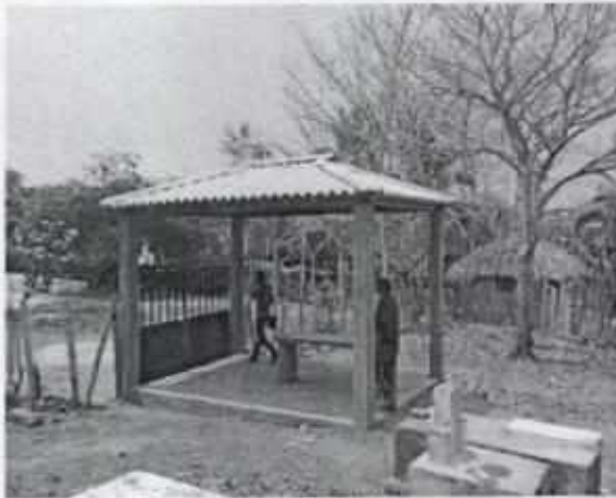
Fig 12 y 13. Plantilla, mesosn en concreto, cubierta en lamina AC y columnas
