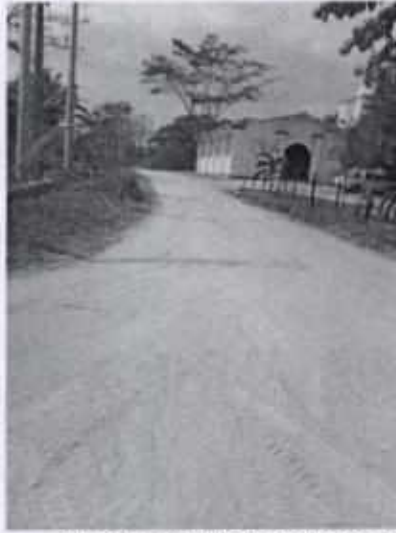
Fig 39 y 40. Mejoramiento de vía con material seleccionado
