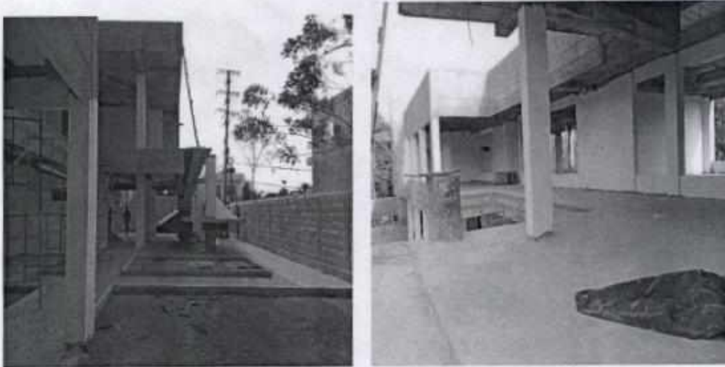
Fig 60. Vista Rampa y segundo piso de la construcción.
