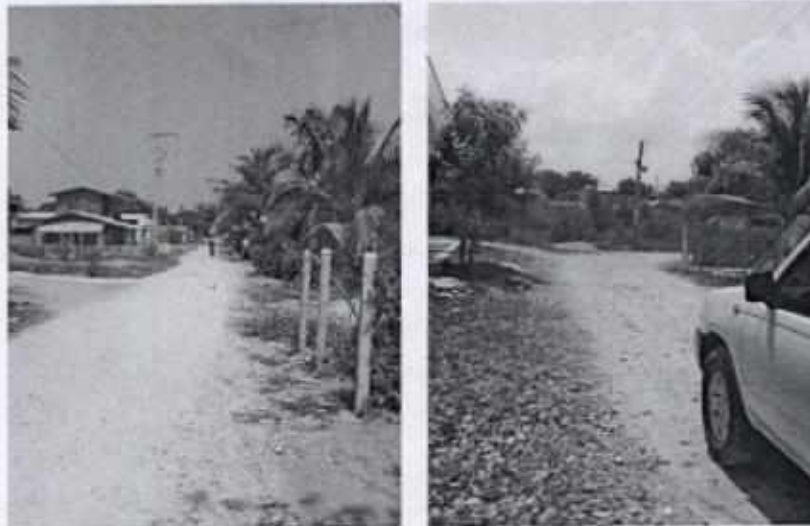
Fig 37 y 38. Mejoramiento de vía con material seleccionado
