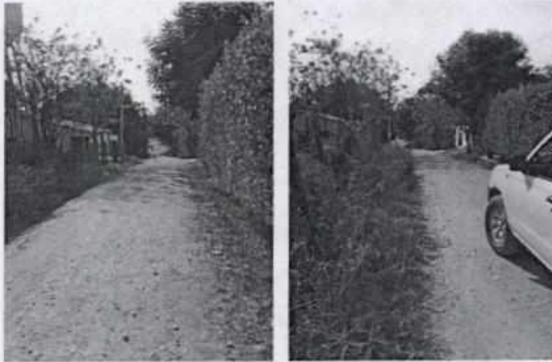
Fig 31 y 32. Mejoramiento de vías con material seleccionado (Sector Guayabal)
