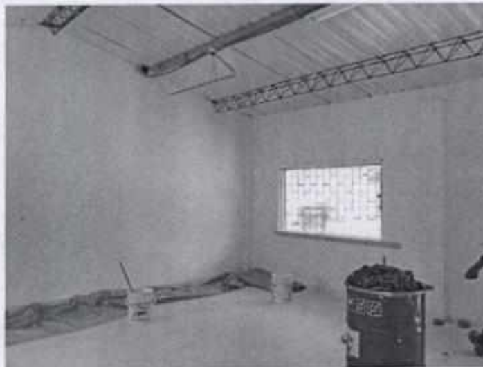
Fig 61. Estado de salon segundo piso.
