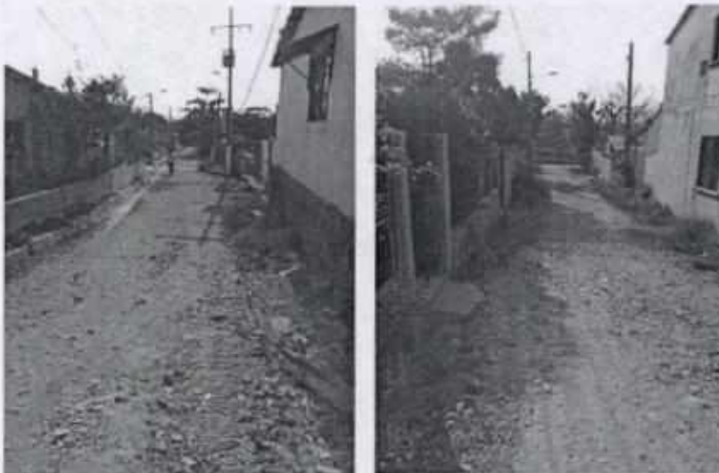
Fig 33 y 34. Mejoramiento de vías con material seleccionado (Calle Las Flores)
