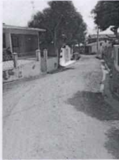
Fig 41 y 42. Mejoramiento de vía con material seleccionado
