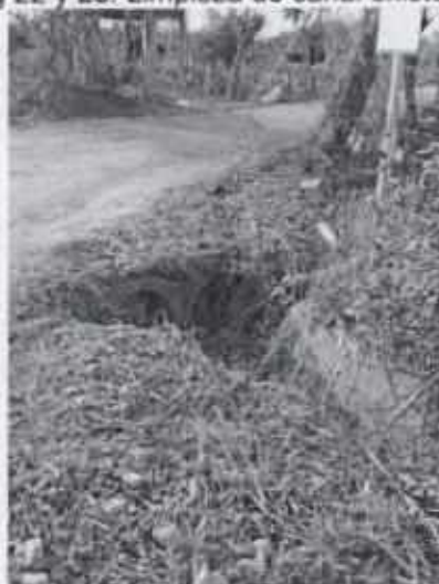
Fig 24. Limpieza de tubería de 18"
