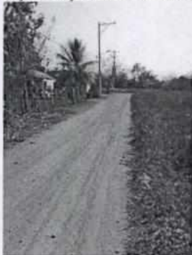
Fig 25, 26 y 27. Mejoramiento de vías con material seleccionado (Sector El Eden)
