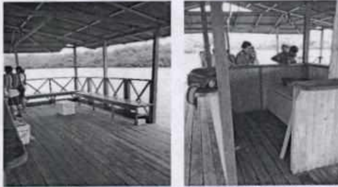
Fig 1 y 2. Plataforma en madera para piso, columnas, cerramiento perimetral y bar construido
