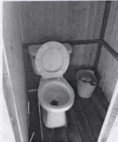
Fig 6. Sanitario instalado en baño
