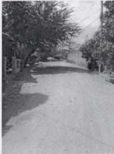
Fig 43. Mejoramiento de vía con material seleccionado
