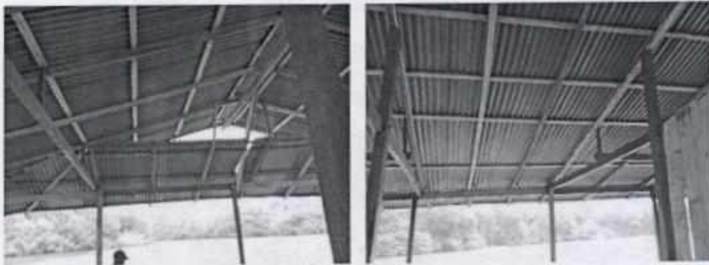
Fig 3 y 4. Entramado en madera y cubierta instalada.
