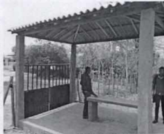
Fig 12 y 13. Plantilla, mesosn en concreto, cubierta en lamina AC y columnas
