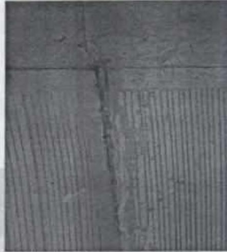
Foto 19 y 20. Fisura en tapa de cárcamos
