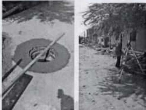
Foto 75 y 76. Fundición de manjoles y trabajos de nivelación de vía
