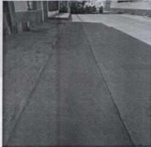
Foto 17 y 18. Construcción de tapa de cárcamos (Aparece contratado como concreto para cunetas)
