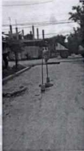
Foto 79. Pavimento terminado y terminación de manholes
